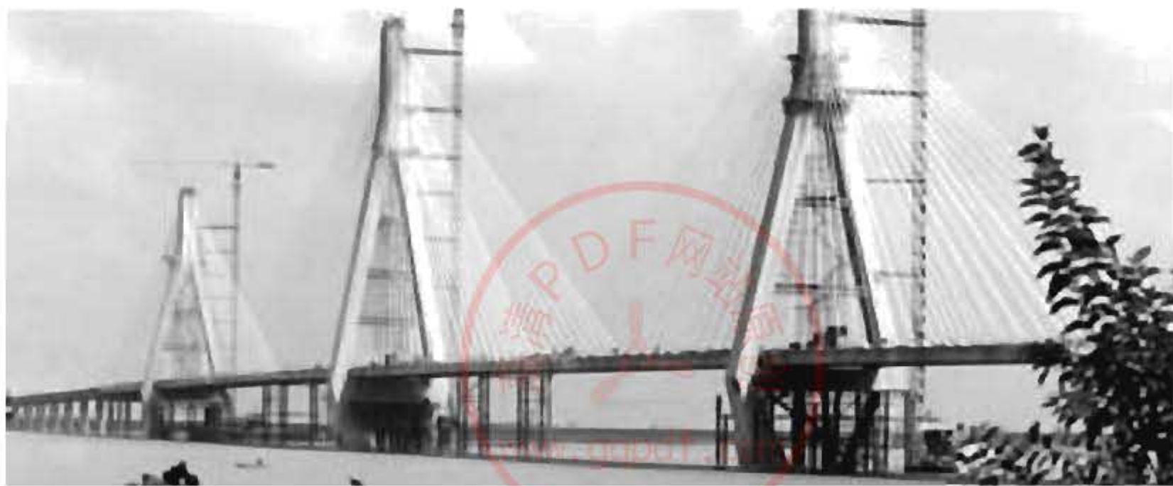
图 12-17 抵抗强风安装有磁流变阻尼器的洞庭湖大桥
