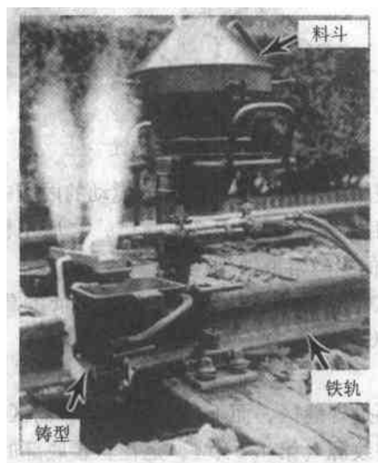
图 7.37 焊接铁轨的铝热剂法 (引自 H. D. Fricke, Metals Handbook [8] , 695 页)
